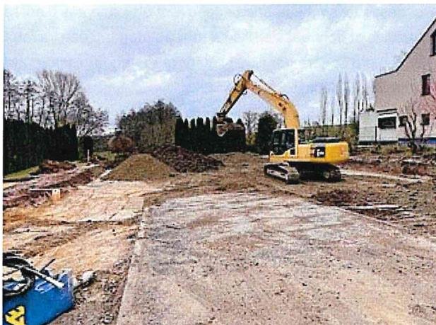
Déblaiement des terres arables sur toute la surface du bâtiment à construire. Terrassement en pleine masse jusqu'au niveau inférieur, ainsi que terrassement des rigoles de fondations resp. du radier et de canalisations suivant les indications des plans de l'Architecte et de l'Ingénieur-conseil.
