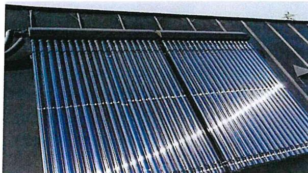
Installation d'un boiler solaire d'une capacité de +/- 300 litres, chauffé par la pompe à chaleur en cas d'insuffisance d'apport d'énergie solaire.
