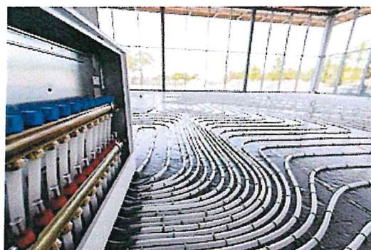
Un chauffage par rayonnement de sol est prévu dans toute la maison (hors local technique, réserve, débarras et garage). Régulation individuelle de la température par thermostats de teinte claire du type SCHUTZ standard ou similaire. Ils sont placés par l'électricien suivant les indications du chauffagiste.
